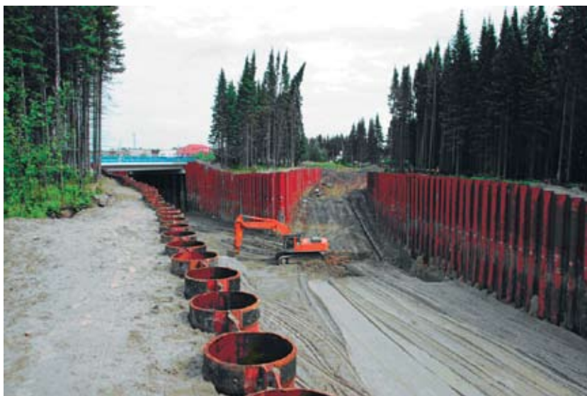
Фото 1. Подпорная стенка из шпунта трубчатого сварного
