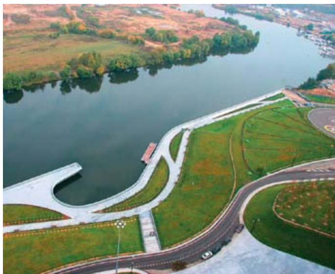
Фото 4. Набережная административного центра в Красногорском районе Московской области, построенная с использованием шпунта трубчатого сварного
