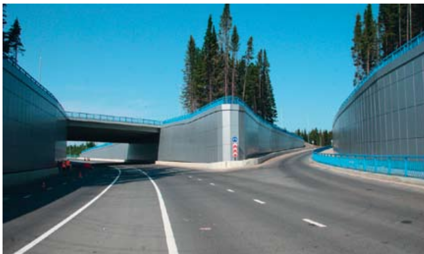
Фото: 3. Объездная дорога г. Ханты-Мансийска с подпорными стенами с использованием ШТС
